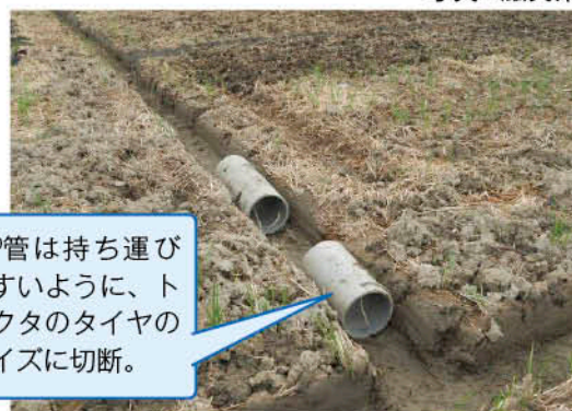
写真⑤：明渠を崩さない工夫
