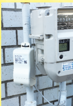
配管へ結束バンド！
