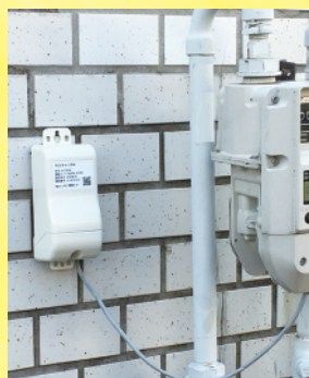
壁面へネジ留め！
